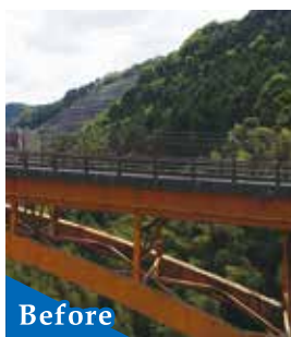
橋梁塗装／浮羽大橋
