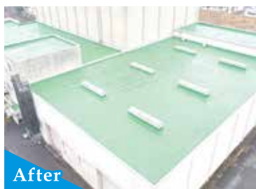
九州大学 屋上防水工事
