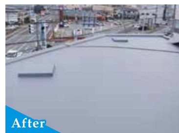
ガラス店 屋上防水工事
