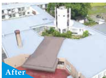
養護老人ホーム 屋上防水工事
