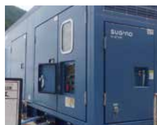
超高压ポンプユニットから アクセスローターへ水送り
