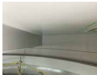
某汚泥処理施設
